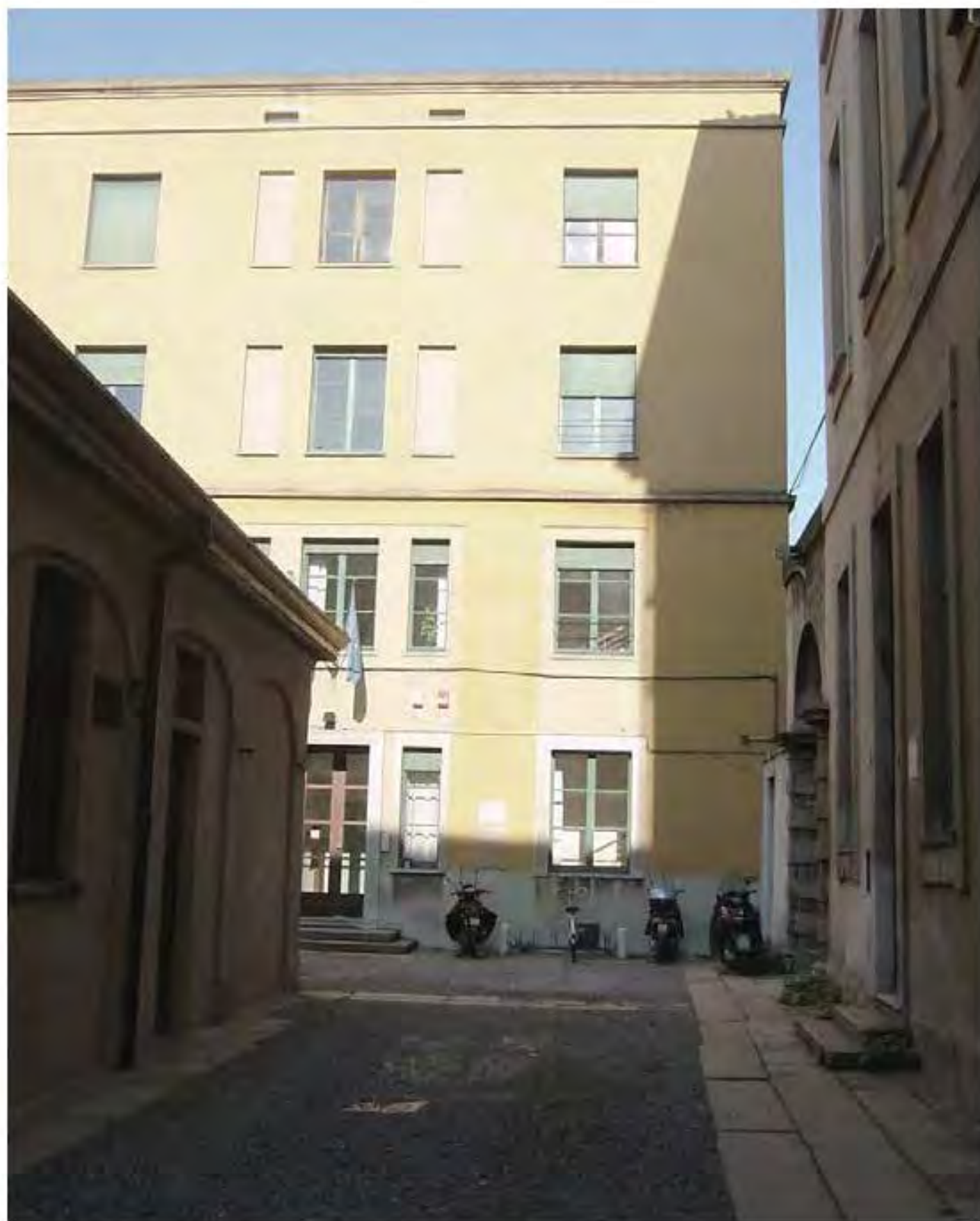
Stato di fatto - Il fronte verso il cortile della Cavallerizza
