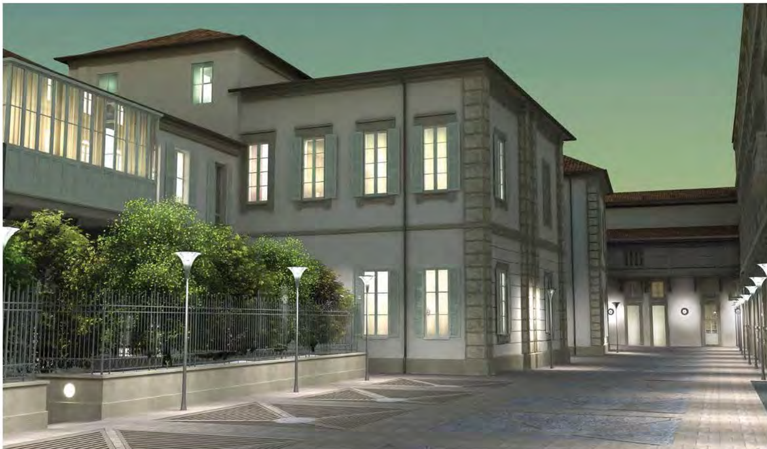
Vista notturna edificio C dal Cortile di Via Illica
