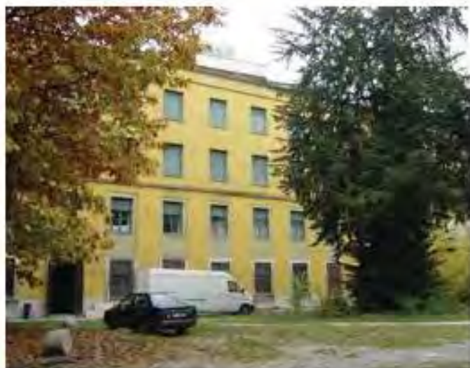
L'edificio A affacciato sul giardino
